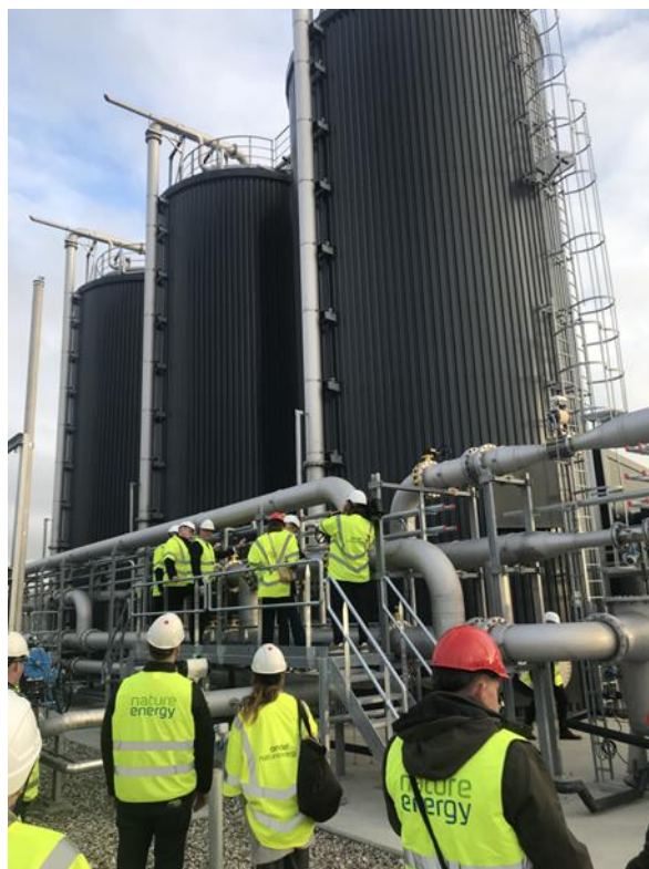
Figur 4. e-metan anlæg indviet på Glansager Biogasanlæg nær Sønderborg den 2. november 2023. Anlægget udgøres af tre metaniseringsreaktorer på hver 380 m 3 , der fremstiller metan ud fra CO 2 og brint
